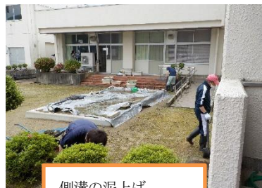
側溝の泥上げ
