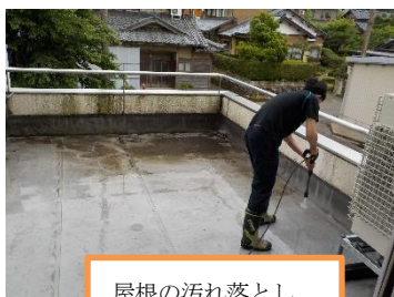
屋根の汚れ落とし
