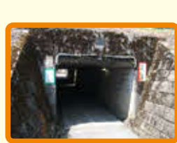
4 ガード下トンネル (暗い)
