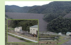
小水力発電所
