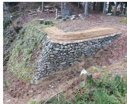
③ 積み直し後、緑化ネットで築堤設置
