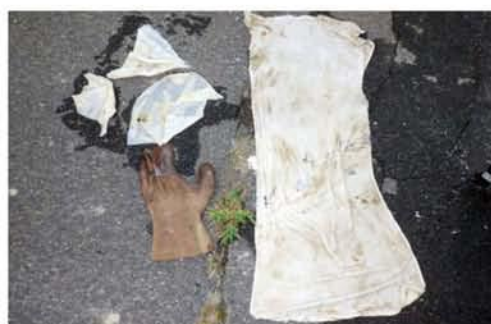
ポンプから取り出された異物(水に溶けない紙)
