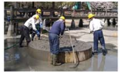
花はす公園での作業風景
