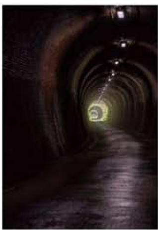
▶ 連なるトンネル
