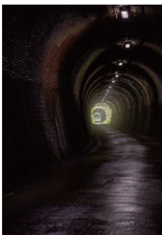
連なるトンネル
