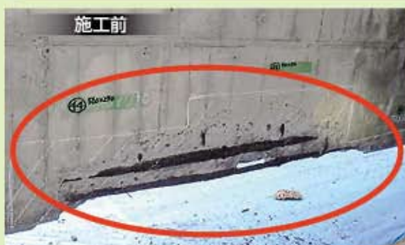
施工前 コンクリート桁の一部が欠け落ちて 露出した鉄筋が錆びている
