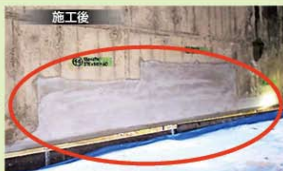
施工後 鉄筋に防錆処理を行ったのちに モルタルで断面を修復し長寿命化を図る
