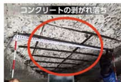
鋼材の腐食
