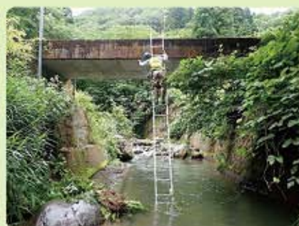
梯子による点検 (岩谷村中線 岩谷村中橋)
