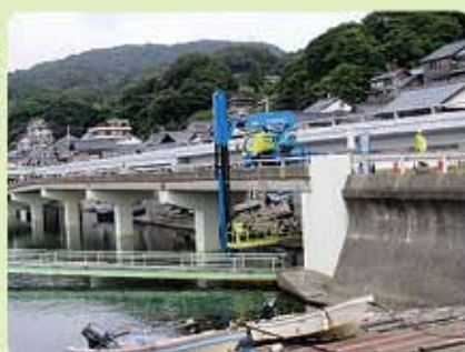
橋梁点検車による点検 (甲楽城3号線 魚揚橋)
