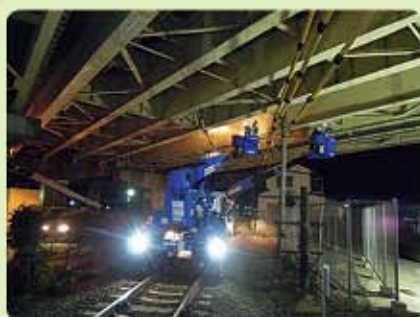
鉄道を跨ぐ橋梁の夜間点検 (国道8号 丸山高架橋)
