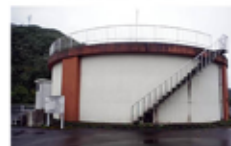
今庄・湯尾配水池
