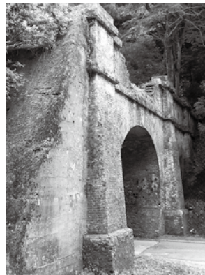
▲山中トンネル
