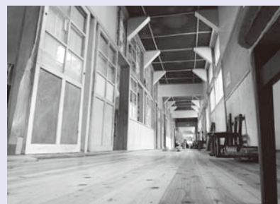
▲廊下の張り直し
