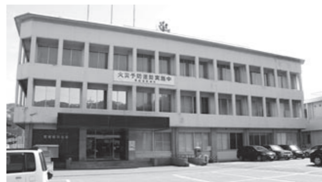
▲耐震大規模改造を実施する役場庁舎
