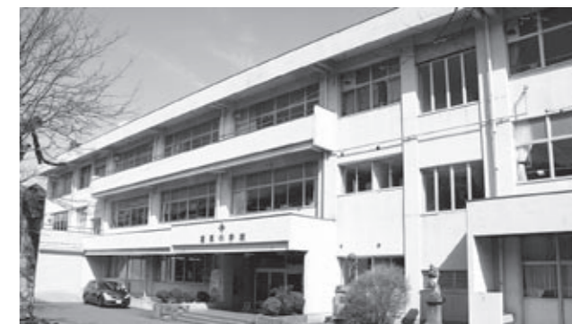
▲耐震大規模改造を実施する湯尾小学校
