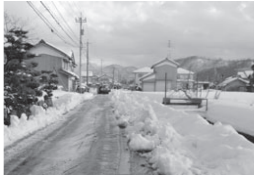
▲ 消雪施設を整備する町道大道脇本線
