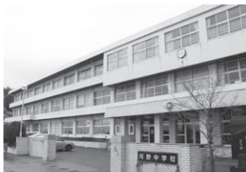
▲ 耐震大規模改造を実施する河野中学校
