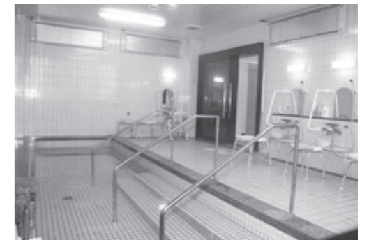
▲ リフト式入浴装置を整備する河野保健福祉センター
