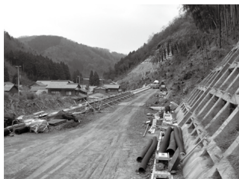
▲ 改良工事中の国道 305 号線
