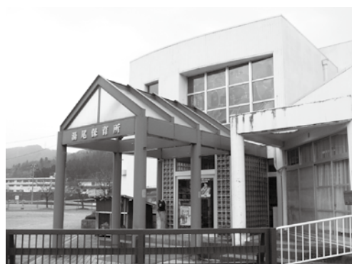
▲ 外壁工事が行われる湯尾保育所
