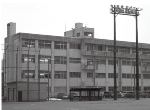
▲耐震大規模改造が行われる南条中学校
