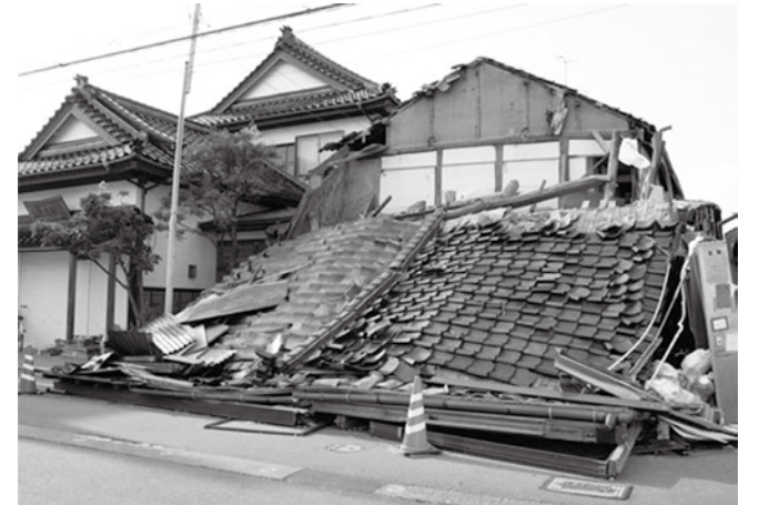
平成 19 年 7 月 16 日に発生した新潟県中越沖地震。倒壊した家屋。
