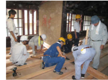
▲ふくいの伝統的民家を若い担い手とともに改修 改修工程において地域の学生に参加してもらい、伝統的建築様式工法の学習の場としました。
