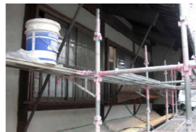
▲ガイドラインに基づく改修工事
