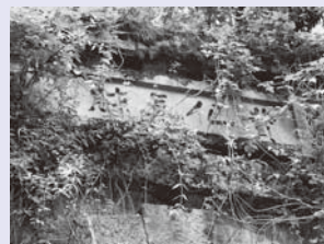
▲旧春日野隧道（現在は武生トンネルに取って代わられている）河野側坑口に残る源慶永（福井藩主・松平春嶽）書『賛化阜財』の扁額
