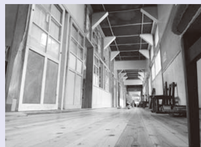
▲廊下の張り直し
