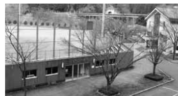
桜橋運動公園野球場
