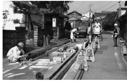
大道地係の融雪工事
