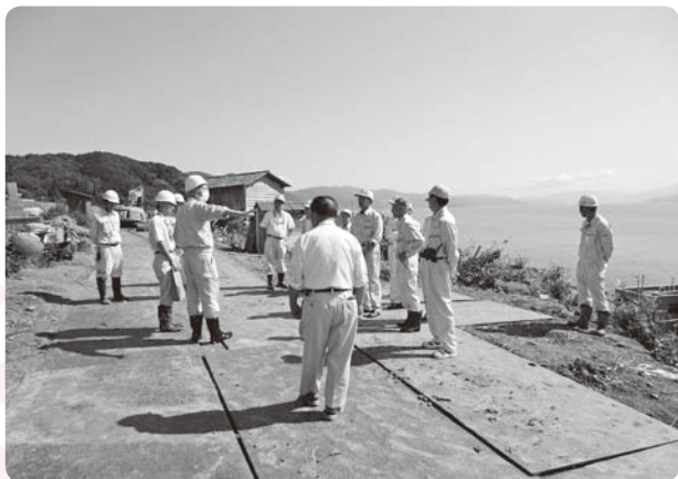
急傾斜地法面崩壊箇所（甲楽城地係）
