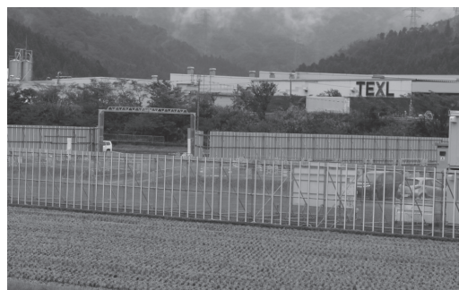
本体工事を待つ新ごみ施設の用地（上野地係）
