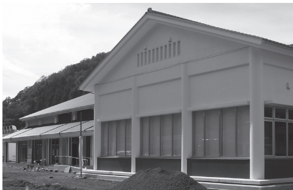
建設中の今庄住民センター
