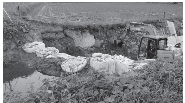
河川の復旧工事
