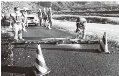
▲電力事業者と連携した電力復旧訓練
