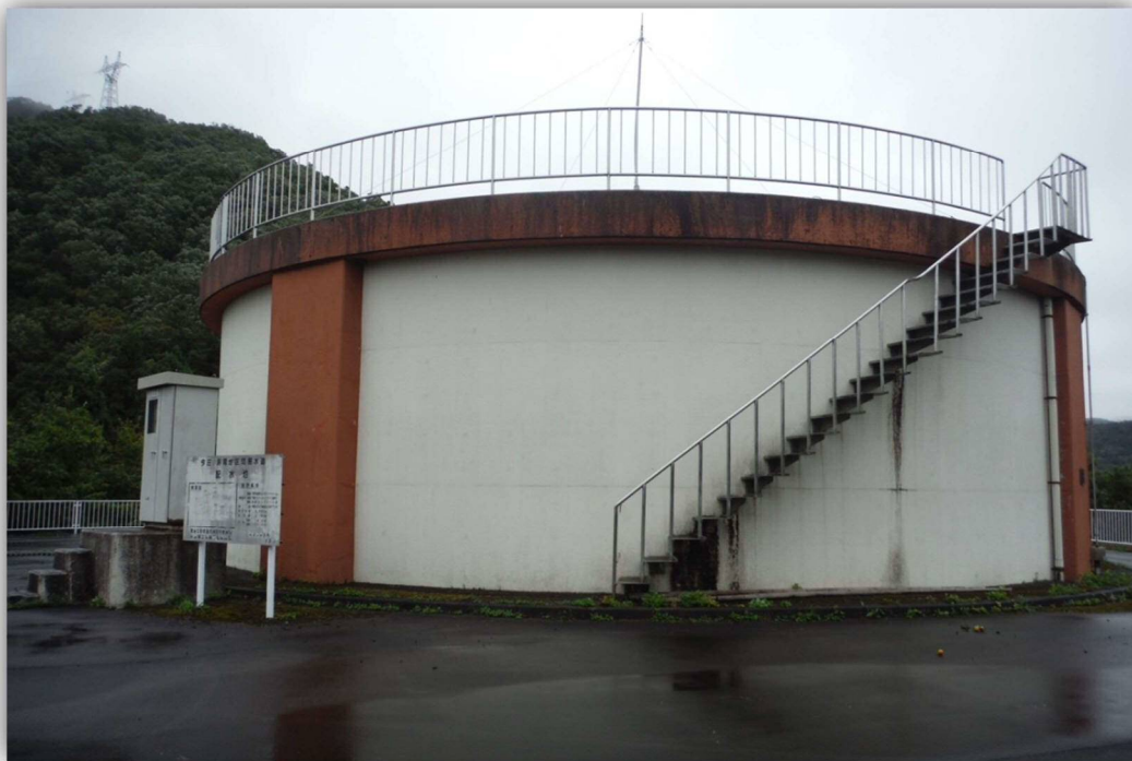
耐震性を有するPC配水池（今庄・湯尾配水池）
