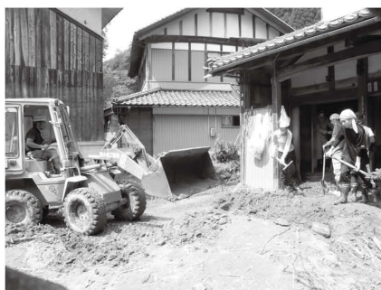
▲泥出しと庭の泥を運ぶ重機
