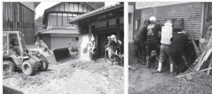
▲泥出しと庭の泥を運ぶ重機
