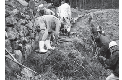
作業を進めると、当時の館の石積みが出てきました。
