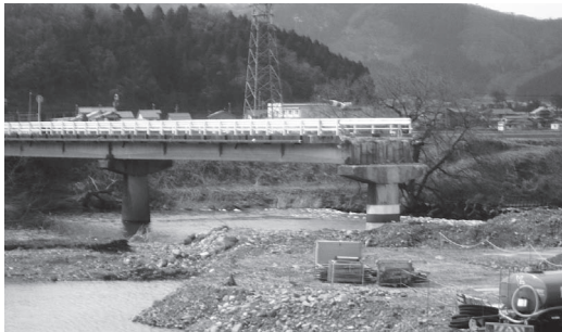
▲架け替えをしている上平吹橋
