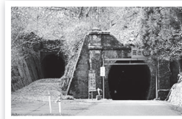
山中トンネル
