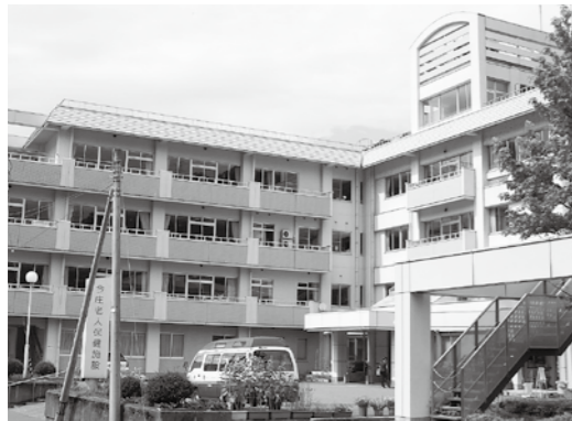
▲4階フロアの改修等が行われる今庄老人保健施設
