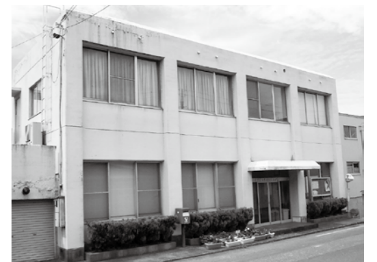
▲地区集会所整備補助金を交付し、屋上防水や外壁補修等を行う東谷生活改善センター
