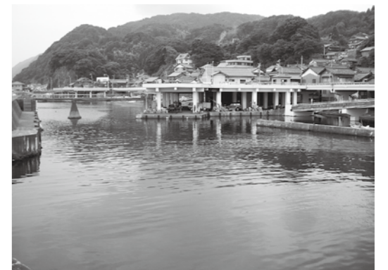
▲浚渫を予定している甲楽城漁港(甲楽城漁港修築事業)
